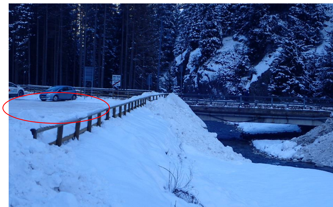
Figura 3.2: area interessata dalla Variante puntuale in argomento; particolare corpo arginale in sx idrografica.
