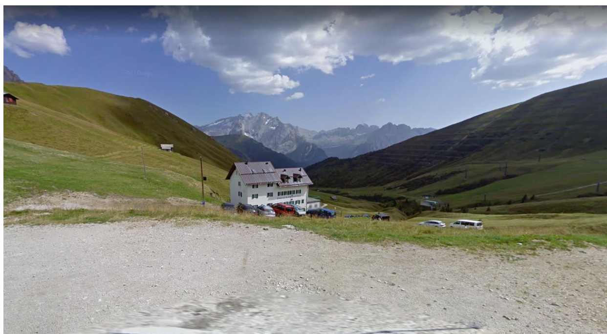
Figura 3.2: Vista da monte dell'edificio oggetto di variante.
