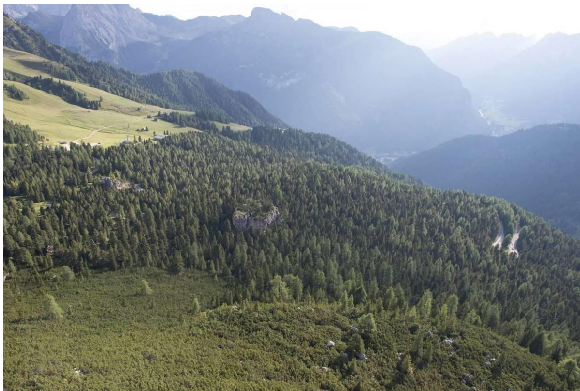
Figura 4.12: Stato attuale - vista da nord dell'area dove sorgerà il bacino "Belvedere".
