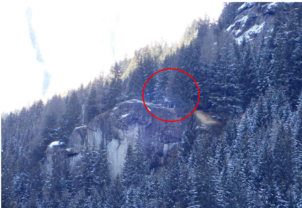
Figura 3.1: Vista dello sperone roccioso sul quale sorge l'edificio oggetto di variante.
