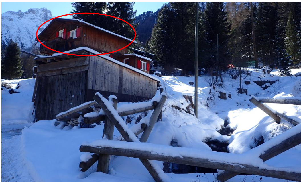
Figura 3.1: p.ed. 640 del C.C. di Canazei, in destra idrografica del rio Cernadoi (vista da valle).
