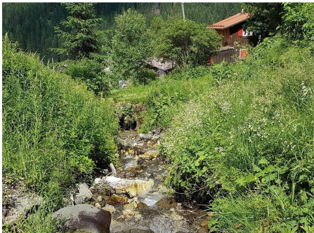
Figura 3.7: vista da monte della tubazione circolare \Phi 1000 poco a monte della zona in oggetto.
