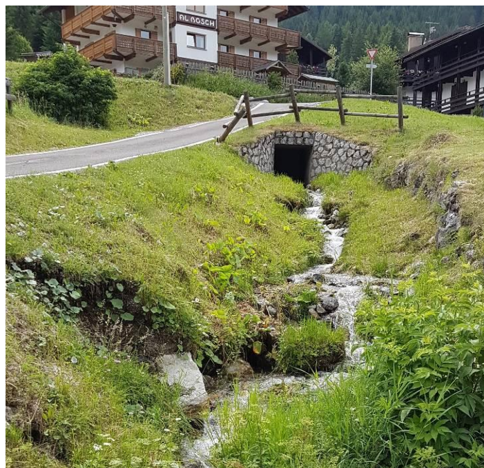
Figura 3.9: imbocco di valle del tombino rettangolare.
