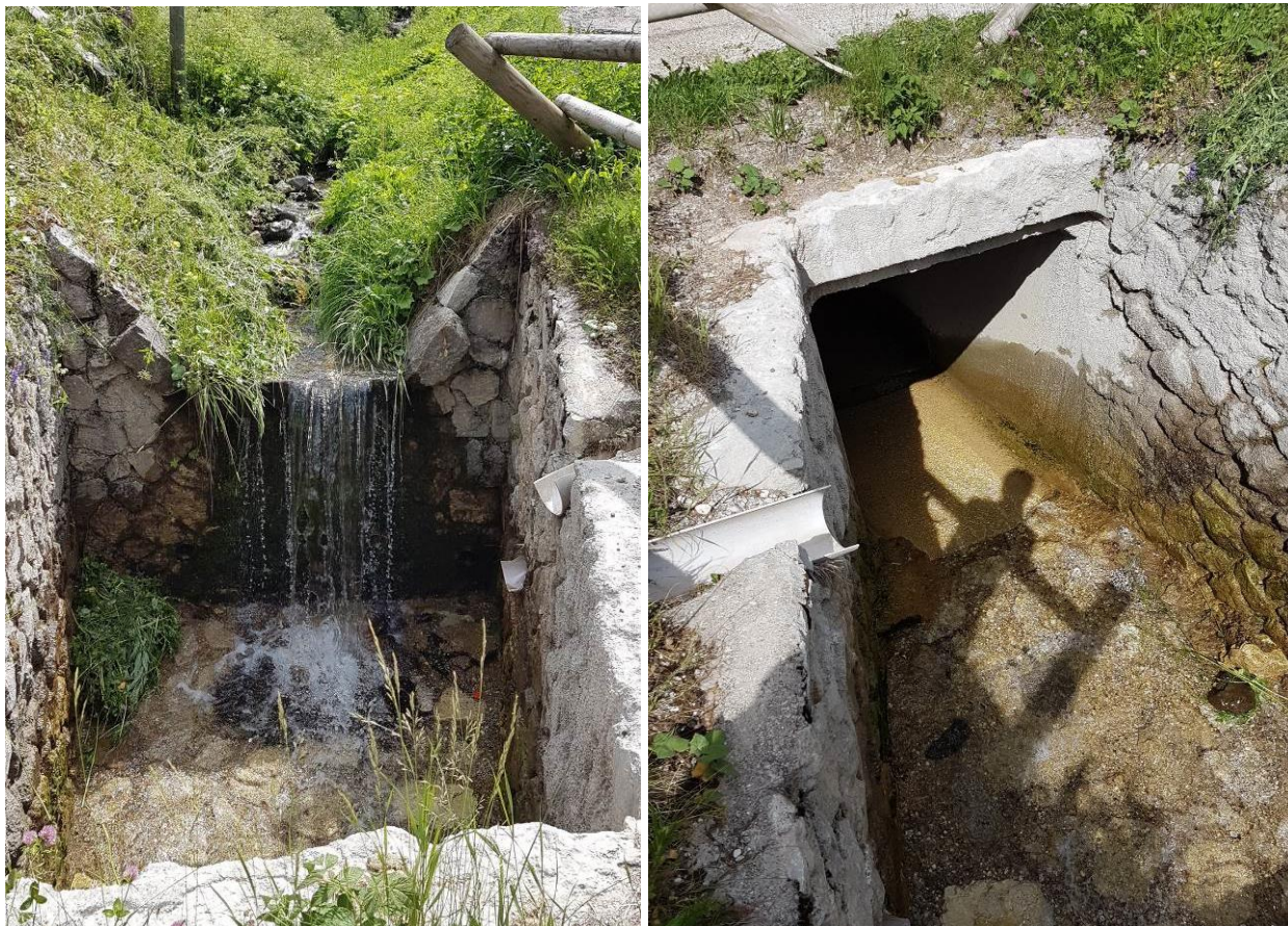
Figura 3.8: a sinistra vista da valle di una briglia a monte della zona in oggetto; a destra imbocco di monte del tratto tombinato a sezione rettangolare.
