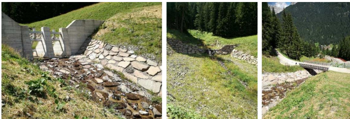
Figura 3.3: nuove opere di protezione realizzate sul rio Cernadoi.
