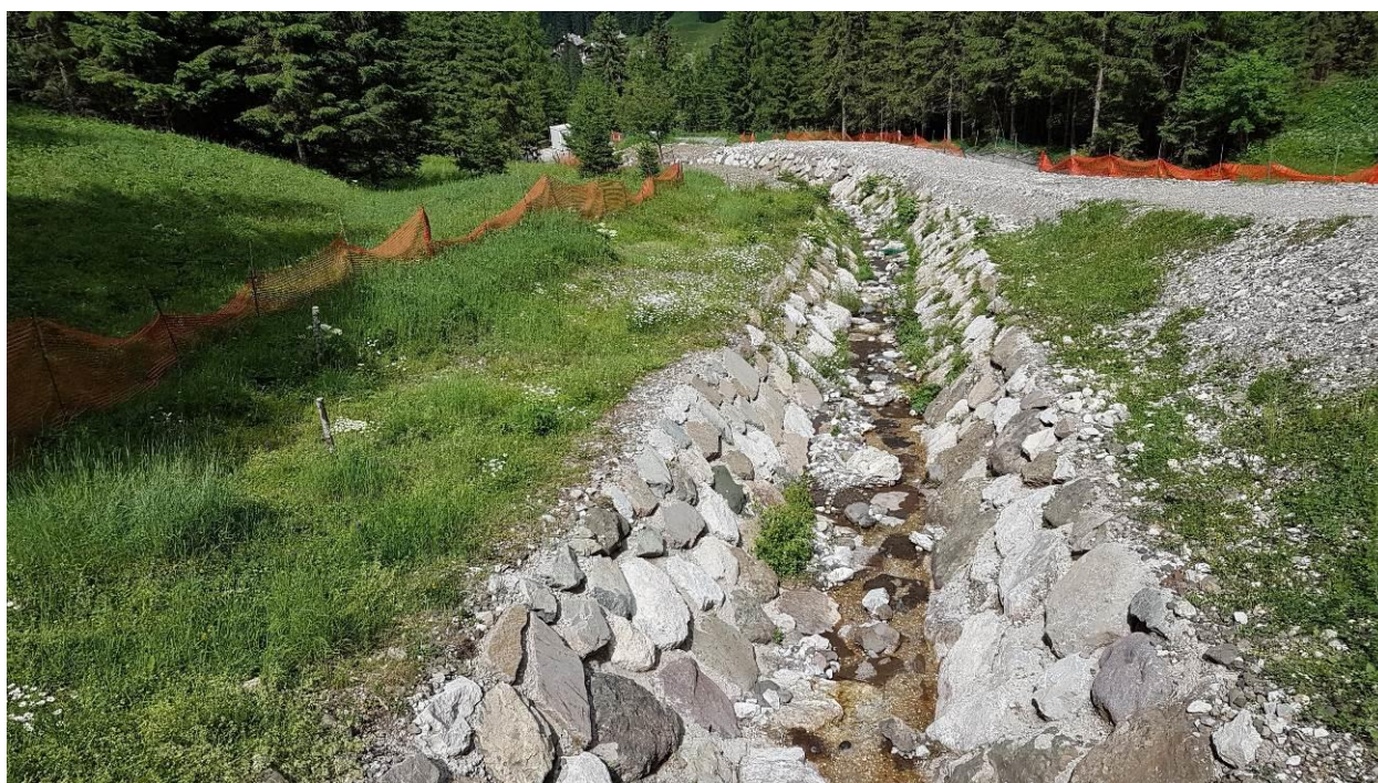
Figura 3.4: cunettone sul rio Cernadoi a valle del ponte della strada forestale.
