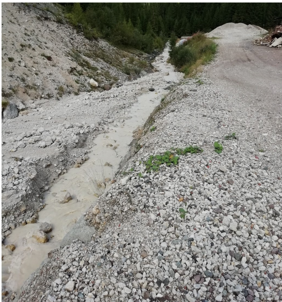
Figura 8) Canale provvisorio di raccolta acque posto al limite ovest della cava, riferito al bacino 1
