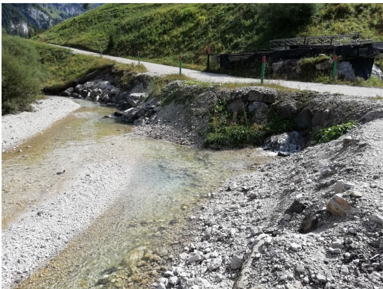
Figura 7) Vasca di decantazione a monte della confluenza con l'Avisio riferita al bacino 2
