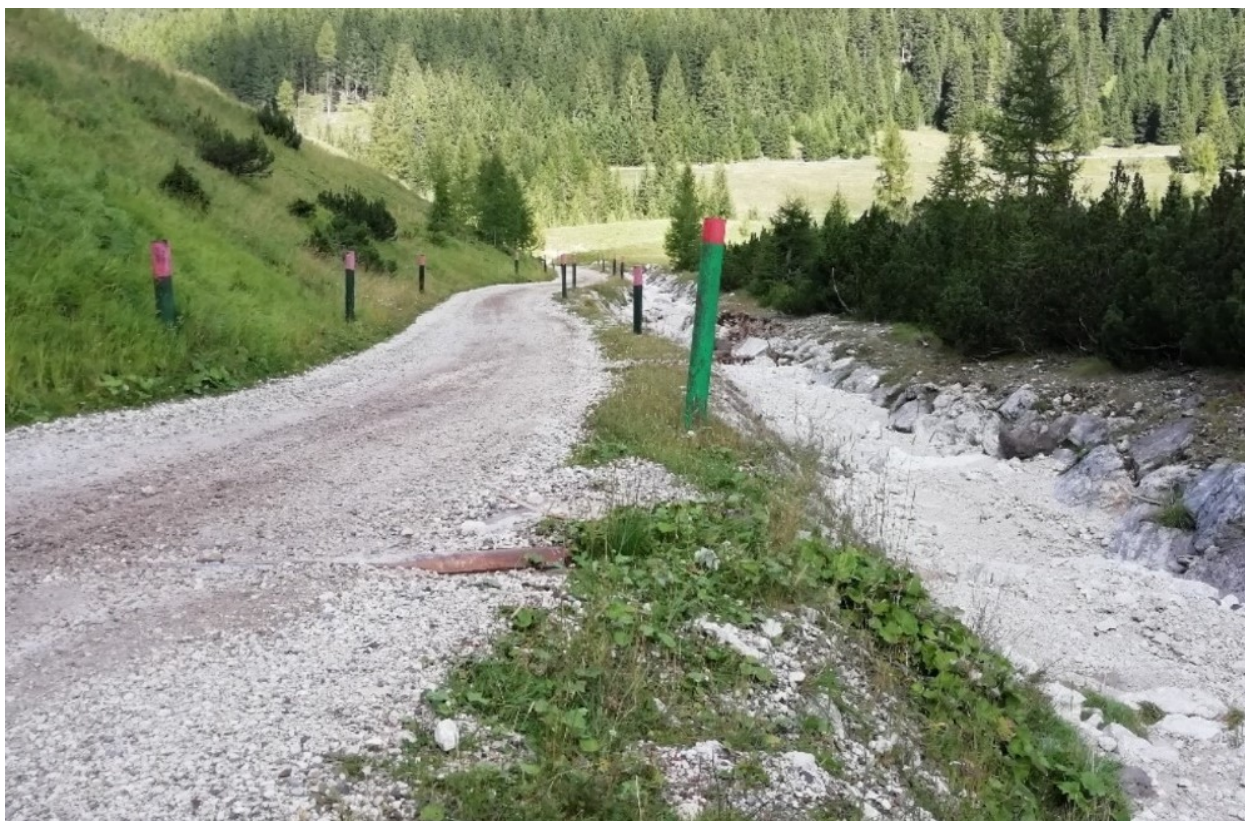
Figura 6) Sulla destra canale di raccolta acque posto al limite est della cava – bacino 2
