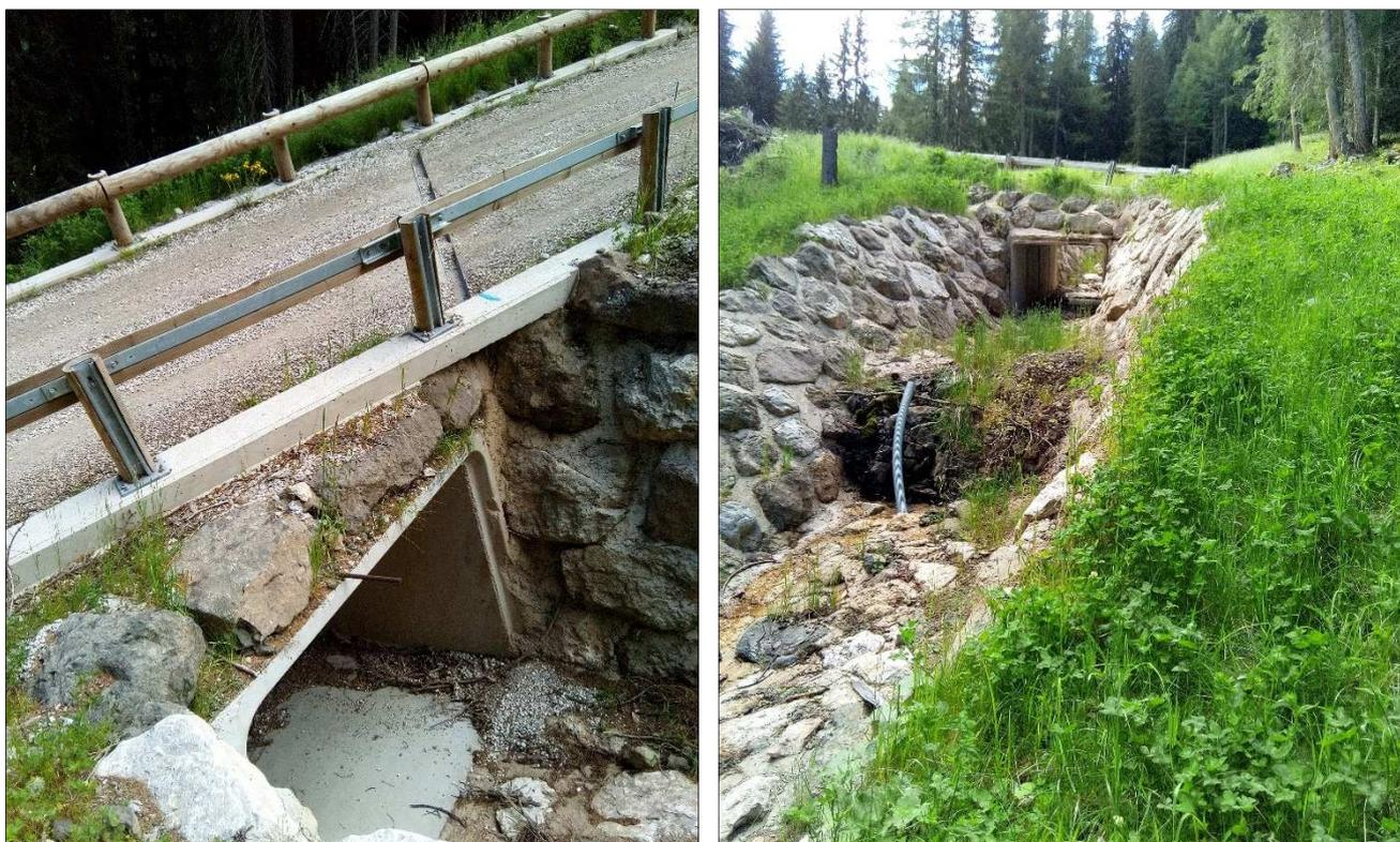
Figura 8.1: attraversamento della strada forestale che conduce ad Alba, in corrispondenza degli interventi previsti dalla variante 26.11 (scatolare in c.a. - 2.50 x 2.00m) - Vista da monte (a sinistra) e da valle (a destra)
