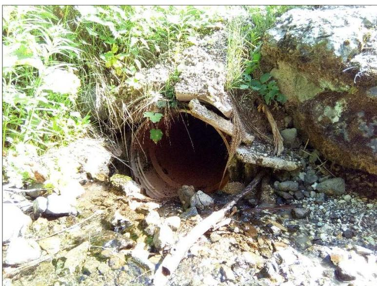
Figura 7.1: attraversamento della strada forestale che conduce ad Alba, in corrispondenza degli interventi previsti dalla variante 26.11 (tubo metallico -  $\phi$  600 mm) - Vista da monte
