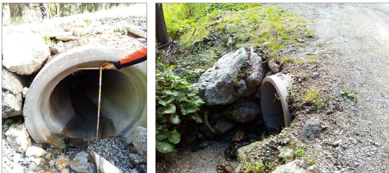
Figura 6.2: attraversamento della strada forestale che conduce ad Alba, in corrispondenza degli interventi previsti dalla variante 26.11 (tubo in calcestruzzo -  $\phi$  1000 mm) - Vista da monte (a sinistra) e da valle (a destra)
