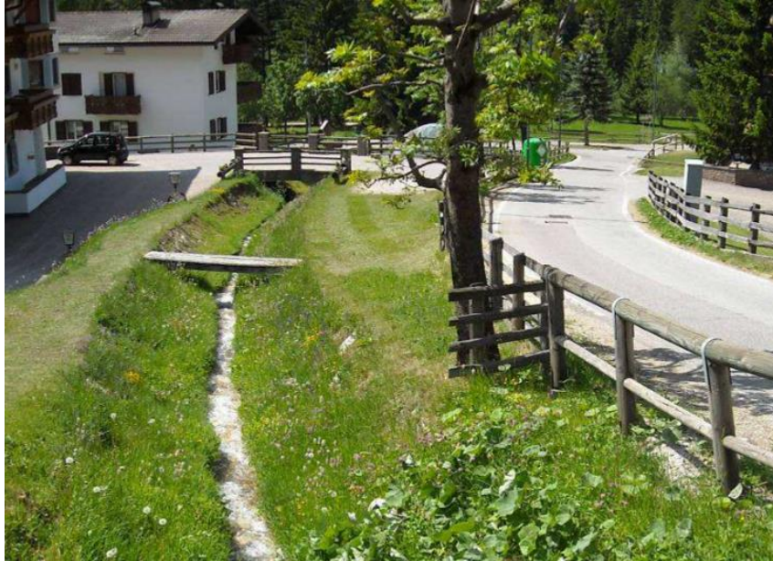
Figura 3.4: vista da monte del rio di Gries in attraversamento alla parte finale dell'abitato.
