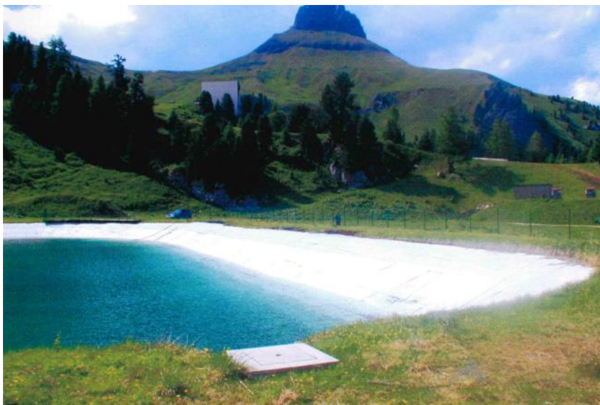
Figura 3.3: Vista da est dell'invaso; in primo piano il pozzetto relativo allo sfioratore superficiale.
