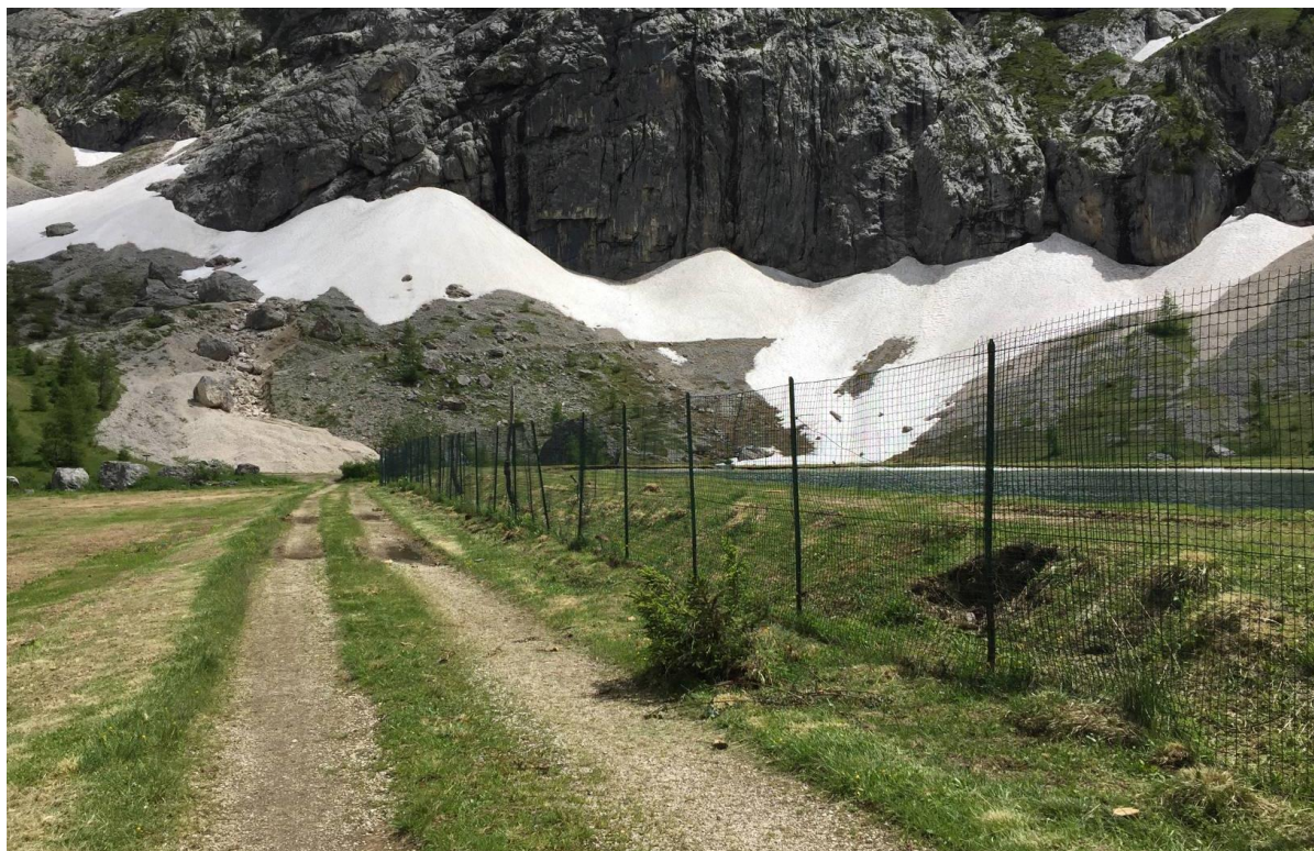
Figura 3.2: Paramento nord dell'invaso.
