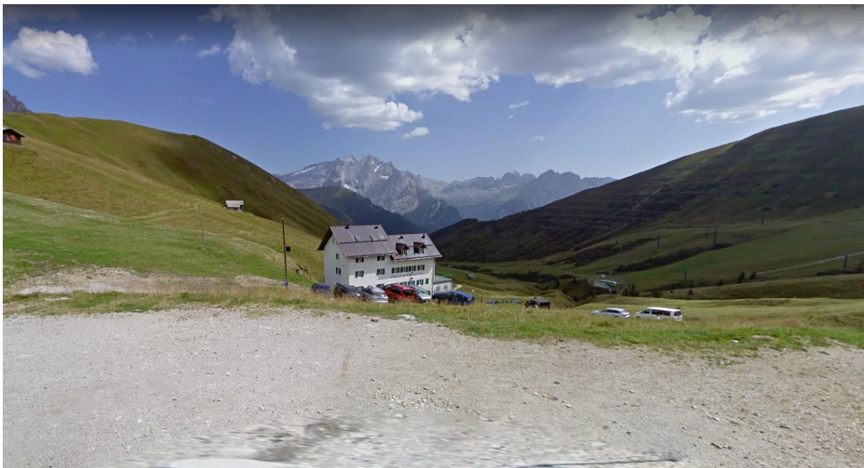
Figura 3.2: vista da monte dell'edificio oggetto di variante.
